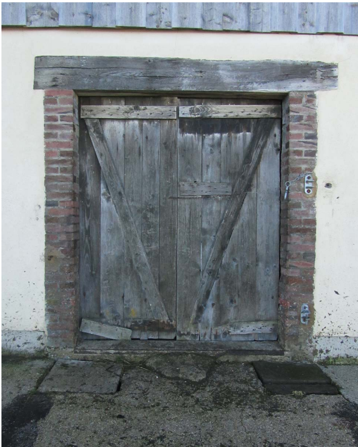
Une porte de grange telle qu'on les aime, rustique, avec quelques giclures de bouse par-ci, par-là, ce qui ne gêne en rien.
